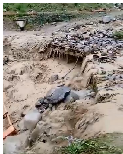
Рис. 3.13. Мостовой переезд к альплагерю, перекрытый селевыми отложениями. Автор фото не установлен.
